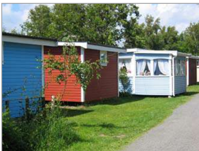
Knölaberget, exempel på inbyggd veranda.
